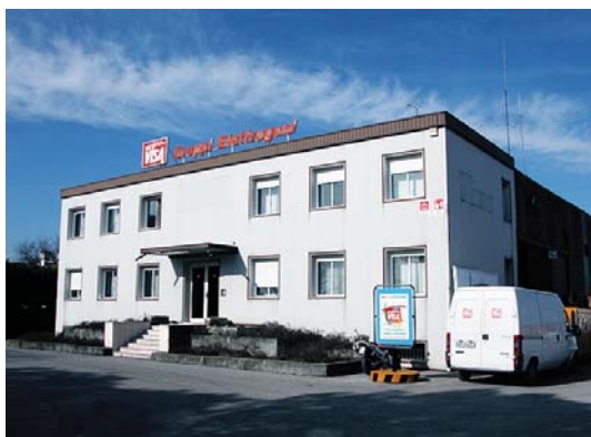
Завод VISA S.p.A. Тревизо, Италия (дизель-генераторные установки)
